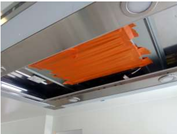
Kuva 3: Liesituuletin tiivistettiin teippaamalla
