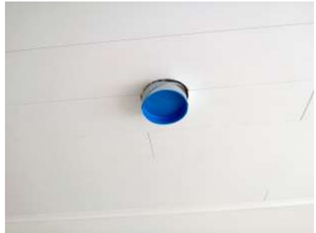
Kuvat 1 ja 2: IV-järjestelmän putkisto oli tiivistetty muovia ja päätykansia käyttäen
