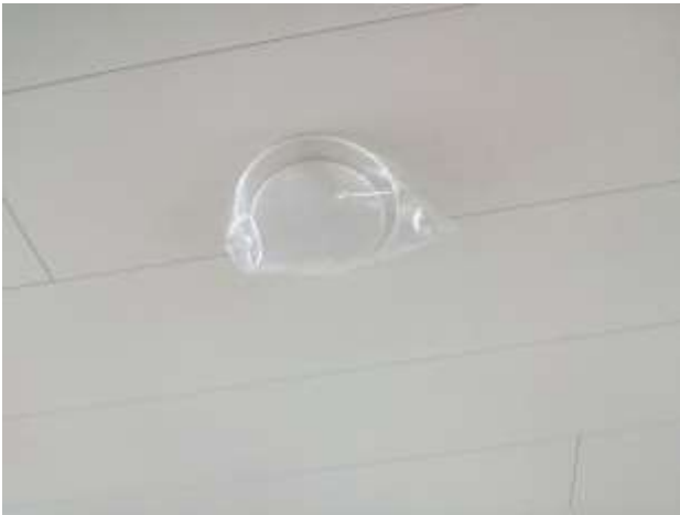
Kuvat 1 ja 2: IV-järjestelmän putkisto oli tiivistetty muovia ja päätykansia käyttäen
