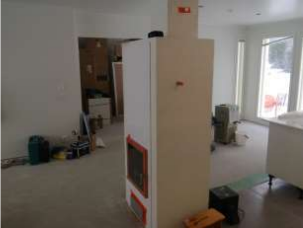
Kuva 4: Tulisija tiivistettiin teippaamalla
